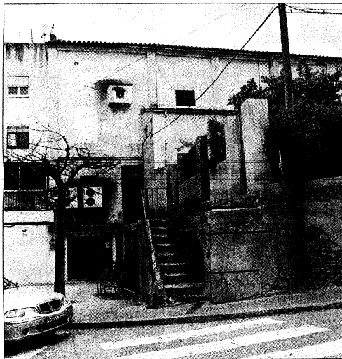
El reg Monar passa canalitzat per darrere de les cases del carrer Calàbria
