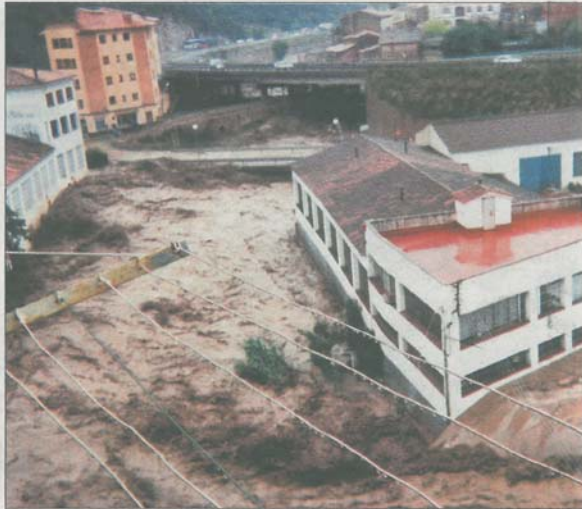
El riu Congost, entre Aiguafreda i Sant Martí de Centelles, envoltant una de les indústries que hi ha al marge dret i que va quedar molt
