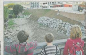
Un nou mur a la Garriga amb escullera i un tram amb bioenginyeria
