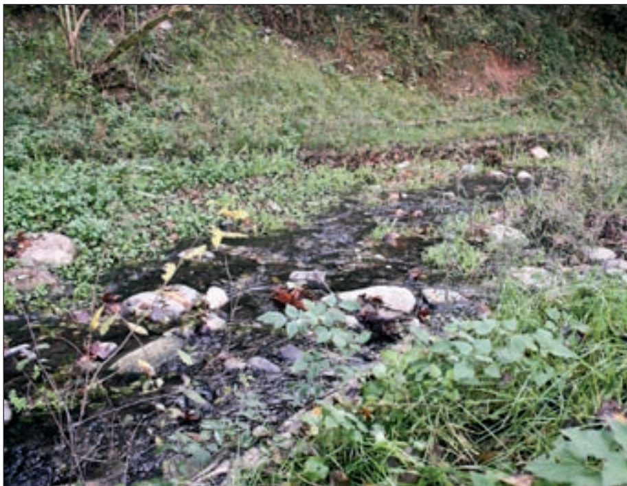
La intervenció va incloure el reforç d'un talús que el riu s'anava menjant amb les riuades
