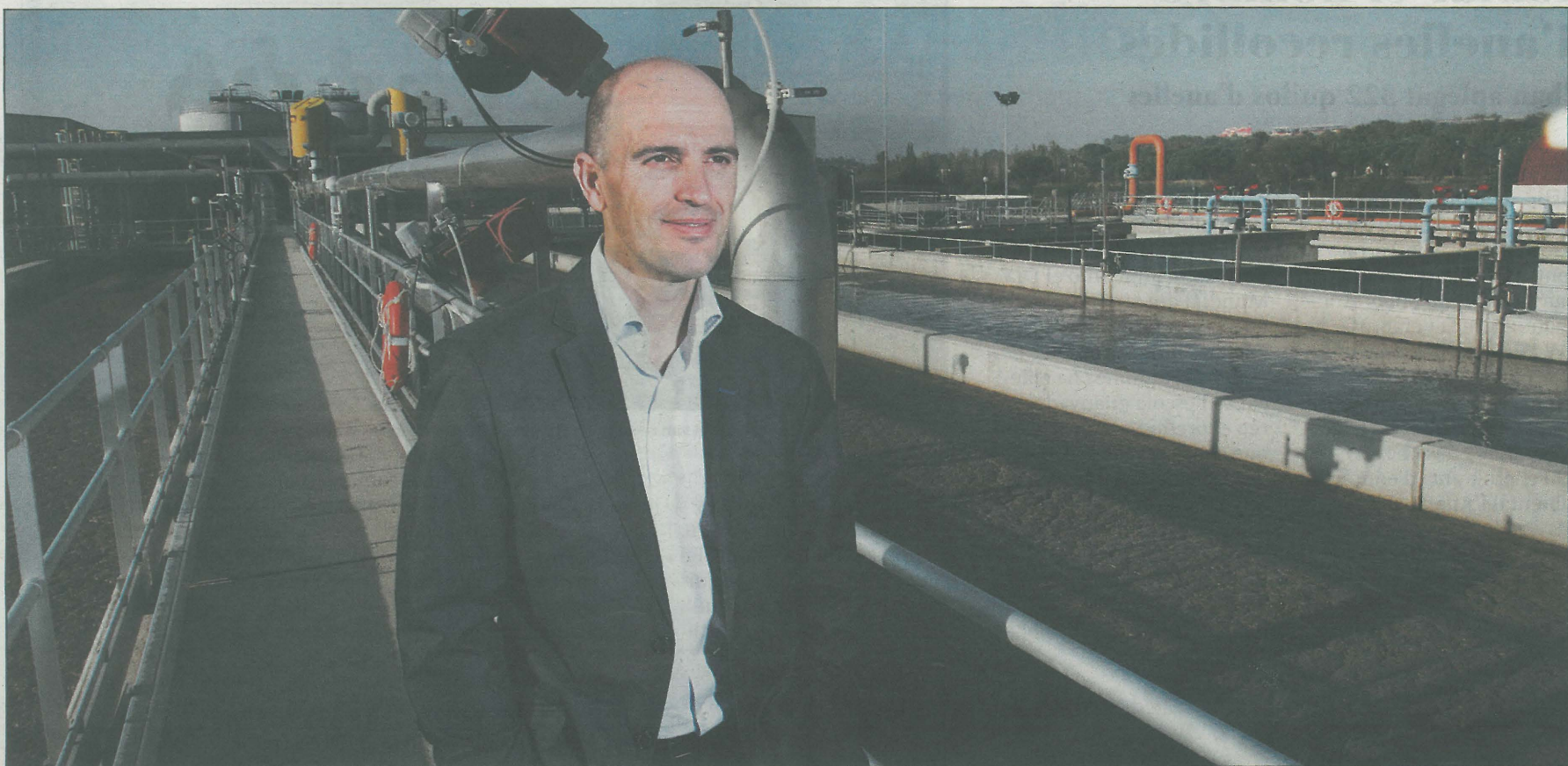
Sergi Mingote, president del Consorci per la Defensa de la Conca del riu Besòs, davant de l'estació depuradora de Granollers, una de les tres depuradores de la comarca que utilitza el sistema premiat.
